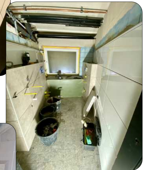
Toilettenanlage während des Umbaus
