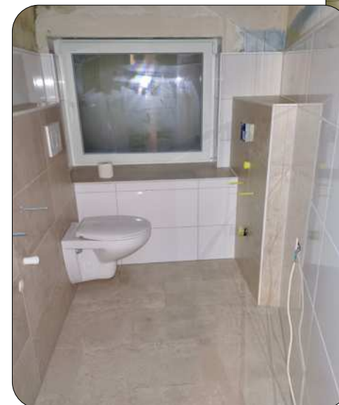
Toilettenanlage kurz vor Fertigstellung
